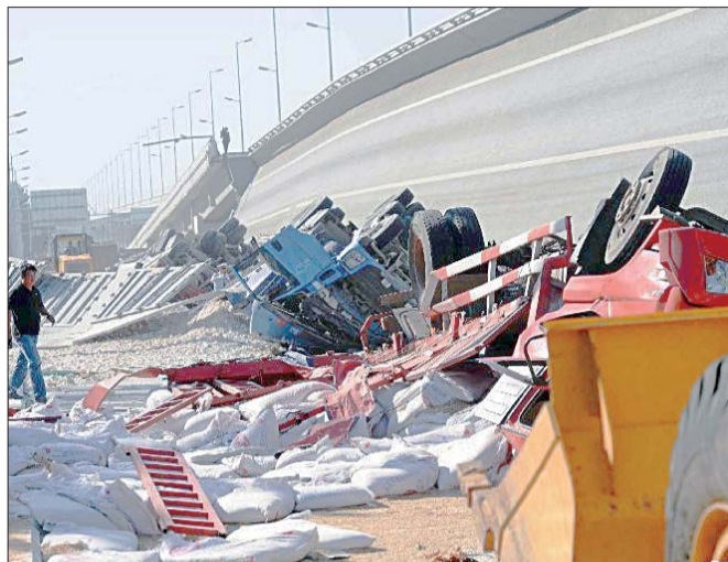
哈尔滨“8·24”塌桥事故现场(资料片)。
