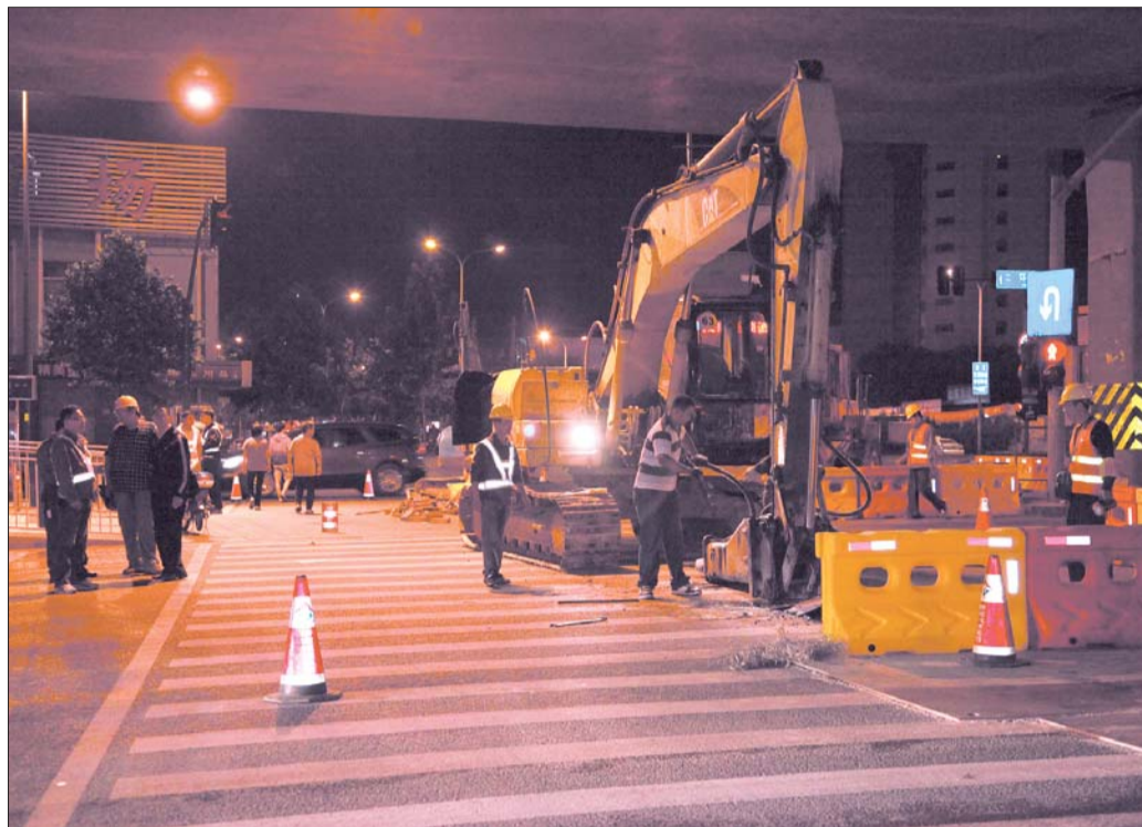
祝舜路隔压站及配套管网正在建设。目前,花园路二环东路路口横穿工程正在夜间施工。 通讯员 韩南 摄
