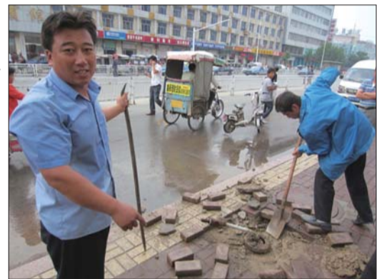
自来水公司工作人员正紧急维修。记者 周千清 摄
