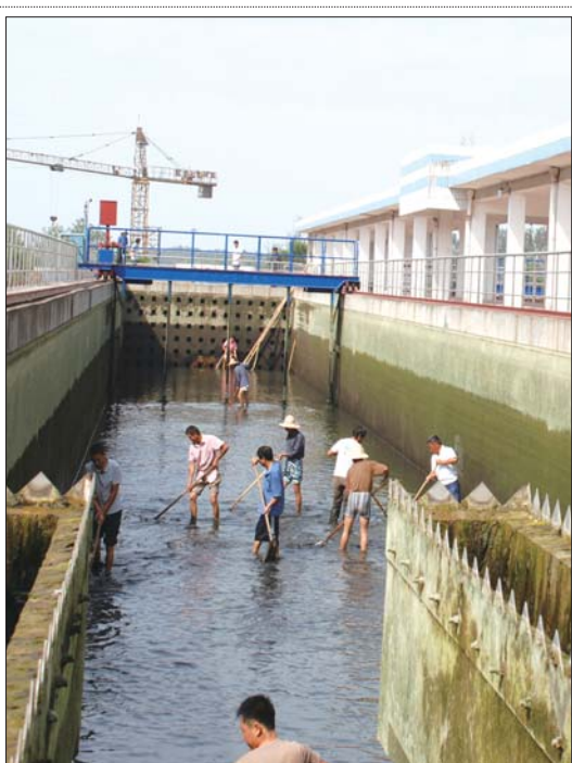
工作人员在清洗沉淀池。本报通讯员 孟华 摄
