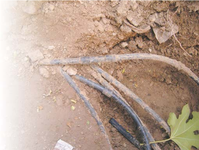
▲在一个坑底，裸露在外的水管根根有“补丁”。
