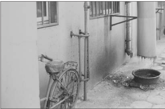
排烟管紧挨天然气管,油渍顺着内壁往下滴。
