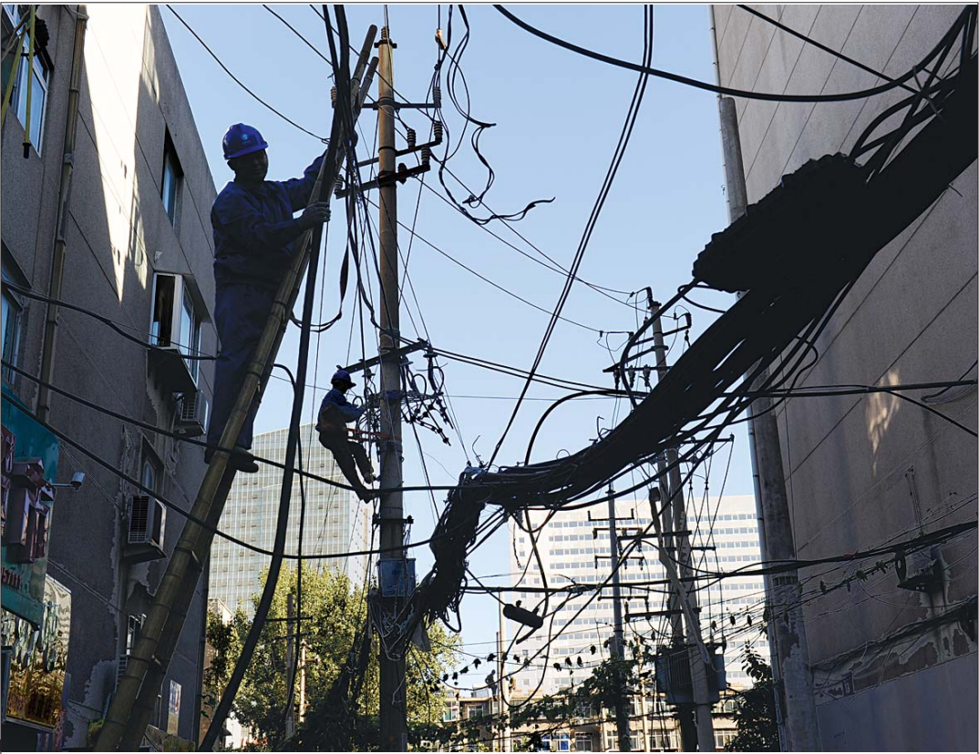
9月28日,在济南市棋盘街小区,电力部门施工人员正在清理杂乱的电线。据介绍,有近50名施工人员对该地段的旧线路进行清理,拆除或更换近20根高压线杆,使得该地区蜘蛛网似的电线得以改观。
