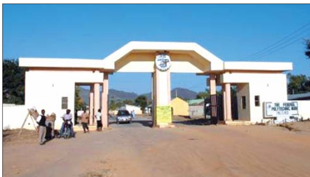
发生枪击案的联邦综合技术学校已暂时封闭。 东方IC供图
