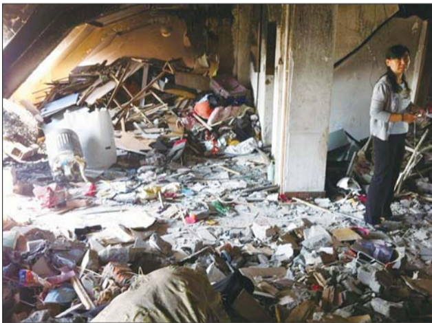
工作人员正对受损房屋测绘。本报记者 钟建军 摄
