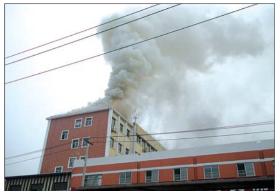
▲机房起火,浓烟滚滚。 本报记者 刘志浩 摄
