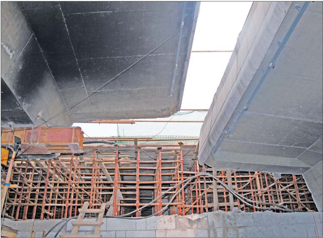
西幅梁体(图左)已经完成顶升高度1.48米。 通讯员 孟晓路 摄
