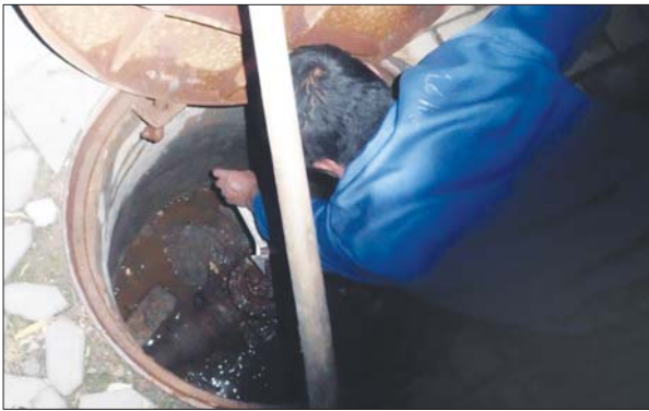
物业人员正在关闭消防栓。(图片由海润自来水公司提供)
