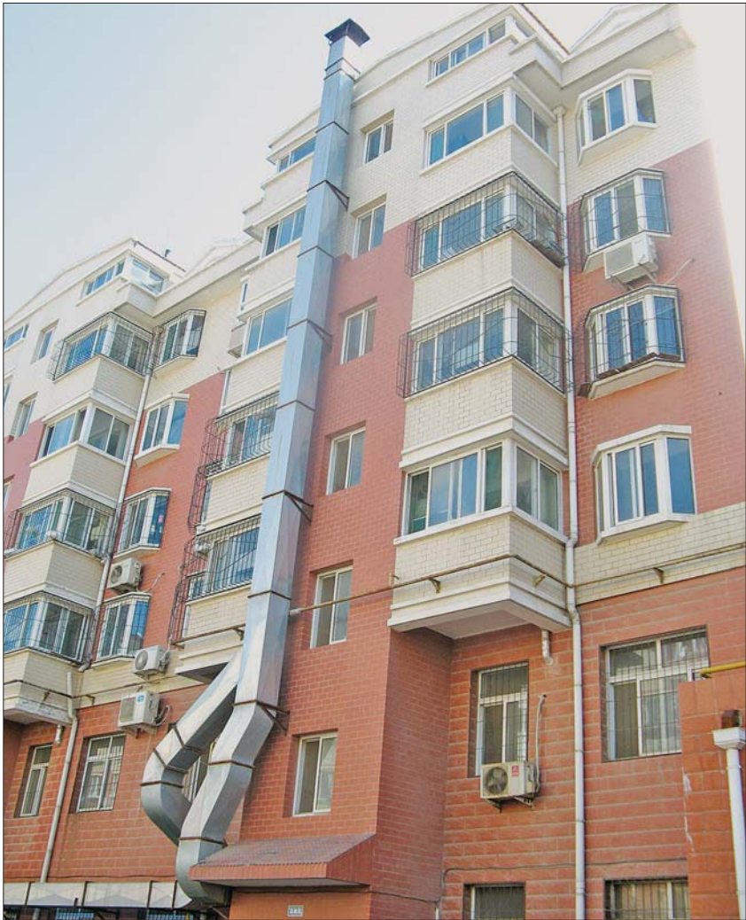
▲在太平洋小区北区的溪翠苑,商住综合楼一楼餐馆架设了十几米高的烟囱,出烟口设到了楼顶。 见习记者 孟燕 摄
