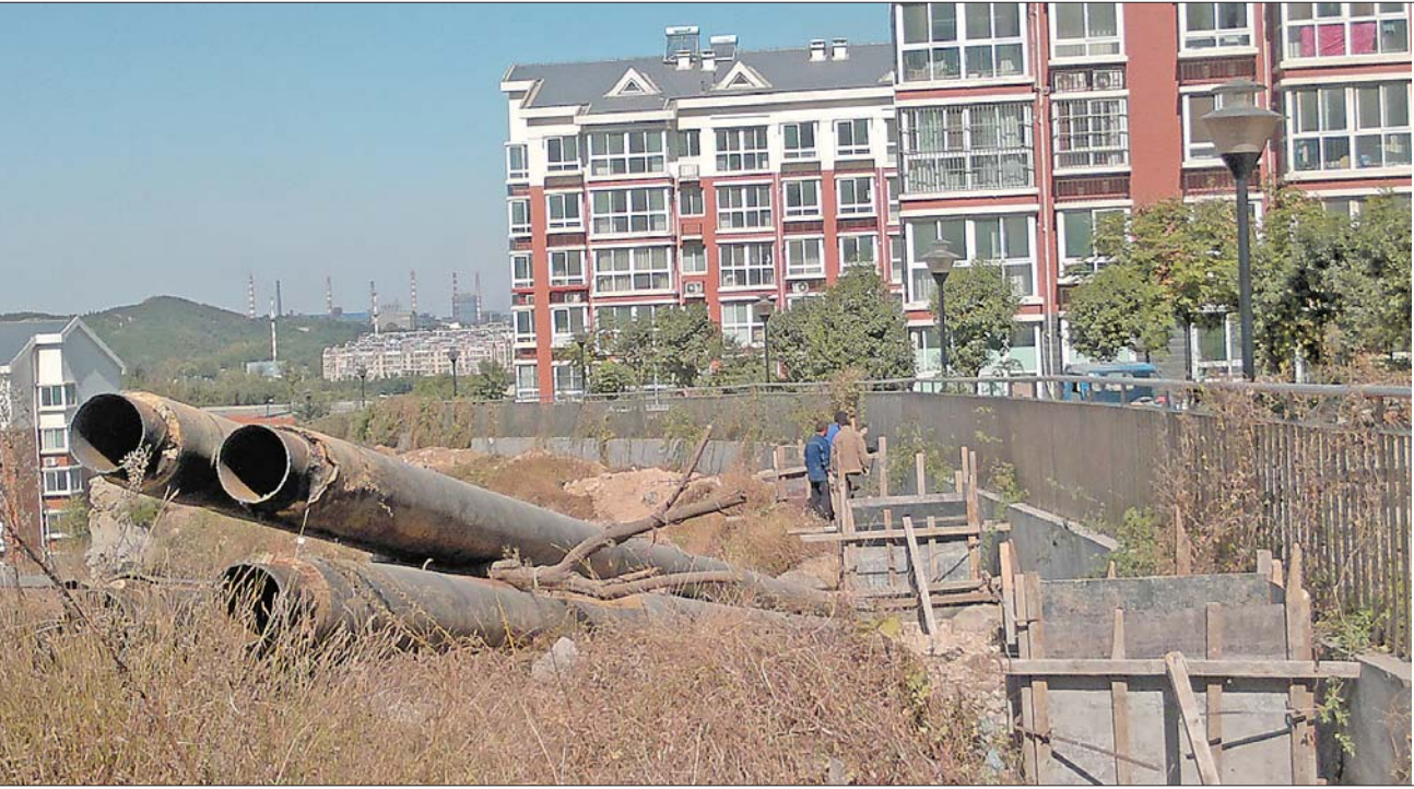
10日,在金河山庄西南角,小区原有的旧管道被挖掘出来,济南热力有限公司的工人正在山体落坡处架设支墩,以便将市政主管网接入换热站。
