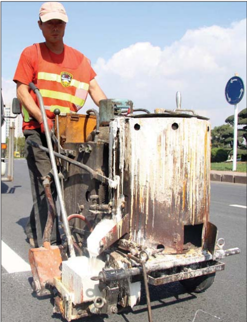
施工人员正在加紧铺设行车线。本报记者 吴凡 摄
