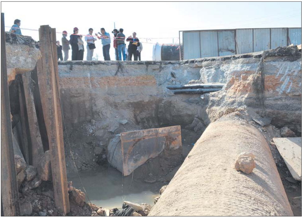
二环西路的供水管道将进行合口施工,图为其中一个连接点。 本报记者 王光营 摄
