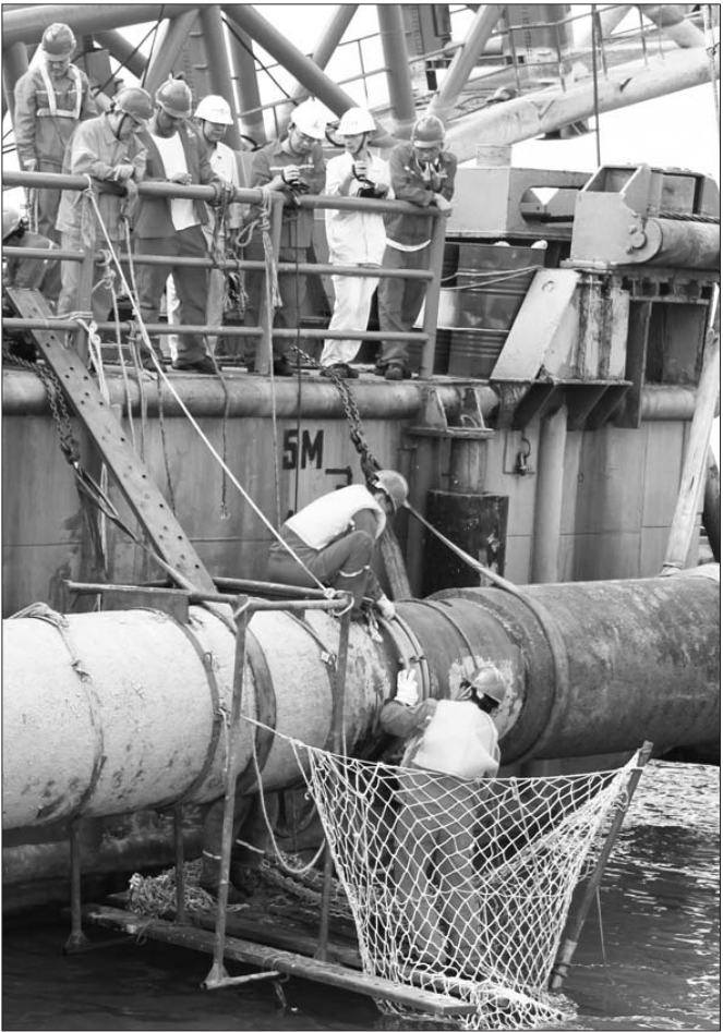
国内最大口径海底管道弯头对接。
