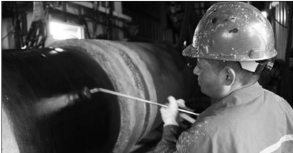
焊工在作业舱焊接管道。
