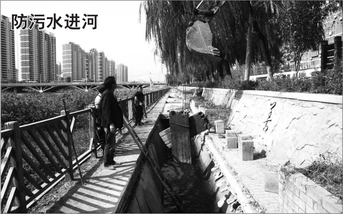
10月11日,施工人员在滕州荆河沿河生态长廊下的排污管道进行改造。据了解,为防止污水向荆河内渗透,滕州市政部门对一千余米的排污管道进行改造,通过铺设管道等封闭式措施,达到疏导污水的目的,预计该工程需要一个多月的时间。 本报记者 孔红星 摄影报道
