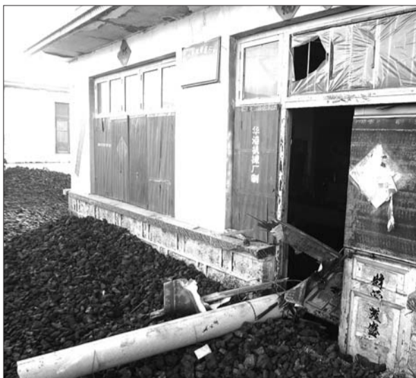
被撞断的线杆砸向附近一户居民的门,焦炭也堵住了门口。
