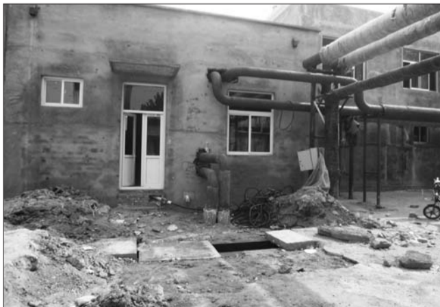
交运小区内的混水站已建设完工,但管道建设被迫停工。
