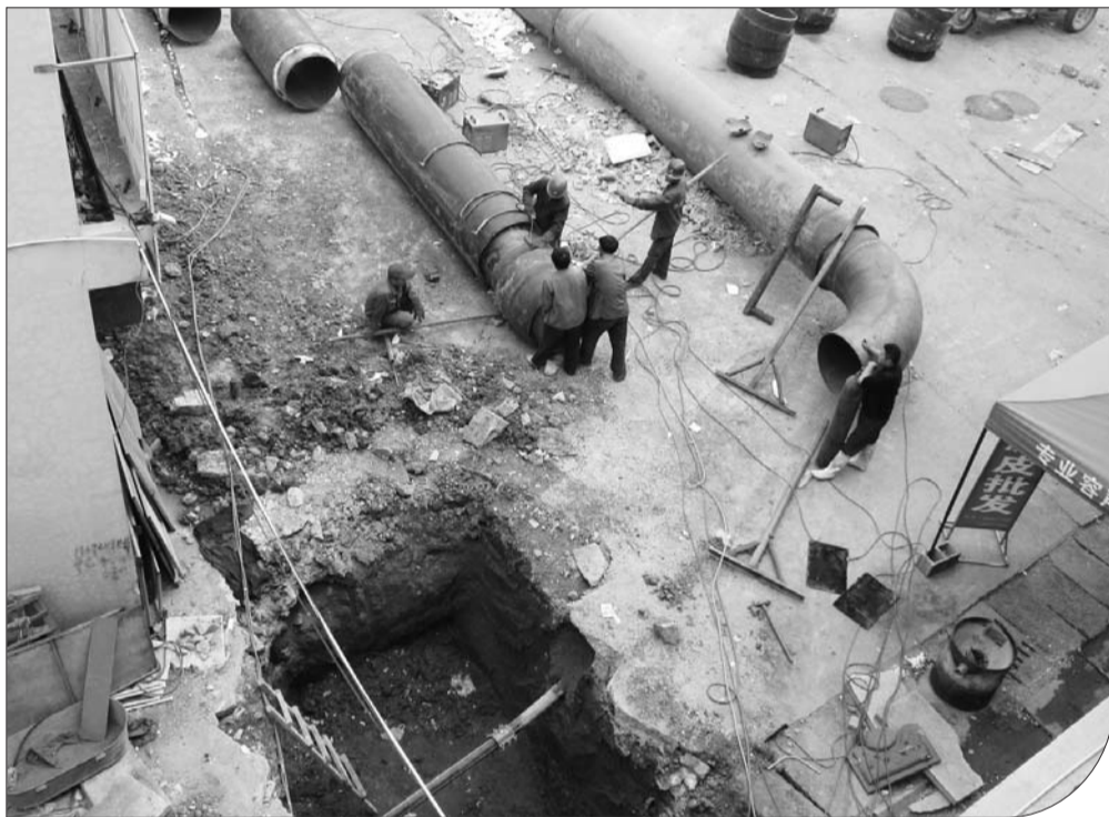
工人正在焊接热力管道。
