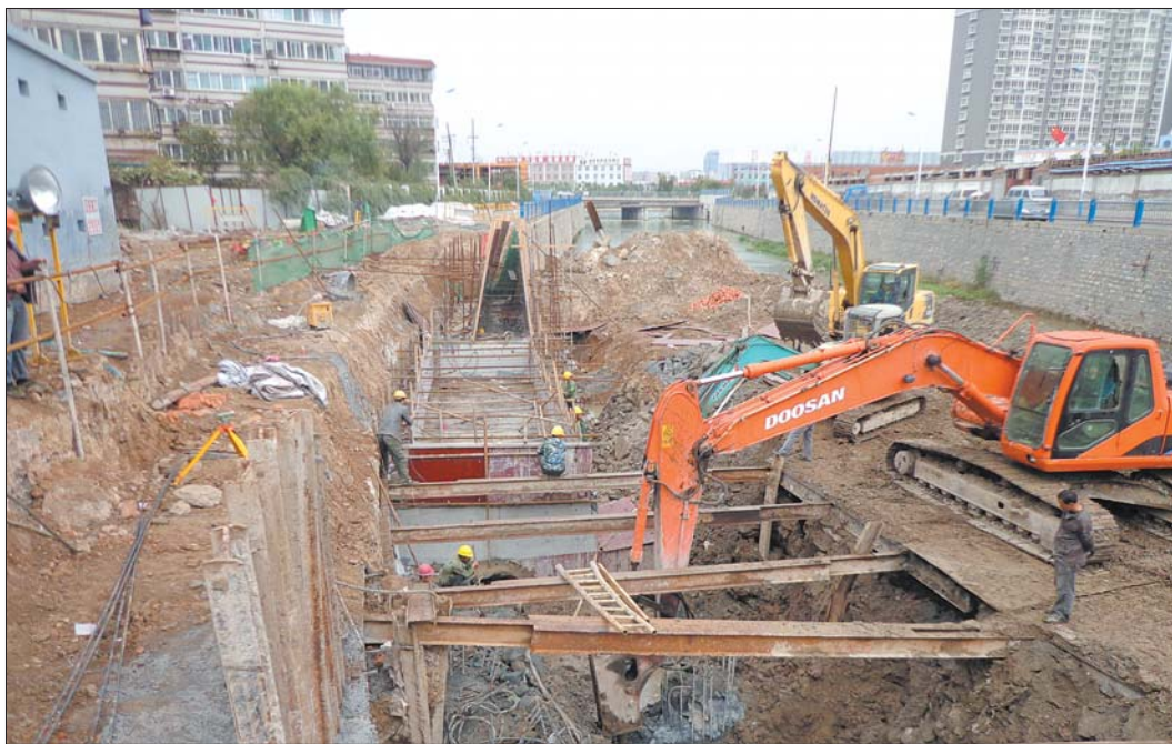
坍塌河段仍在施工。本报见习记者 叶嘉利 摄
