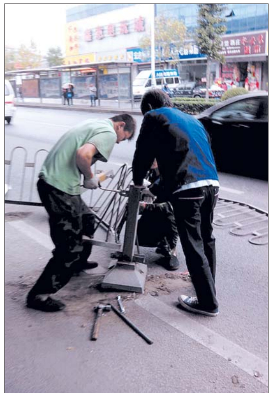
工作人员正在维修护栏。 读者 魏丽蕊 供图
