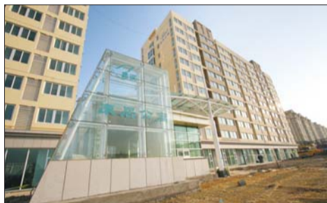
康居公寓是全国最大集中建设的廉租房小区。
