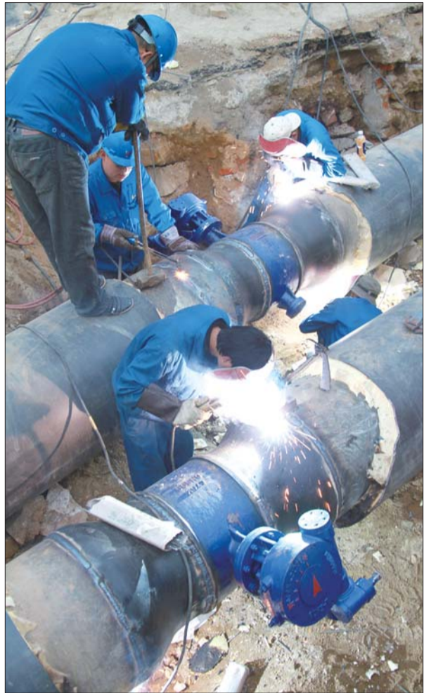
在新威路段,工作人员在加紧施工,以保障主管道提前铺设完毕。 本报记者 王震 摄
