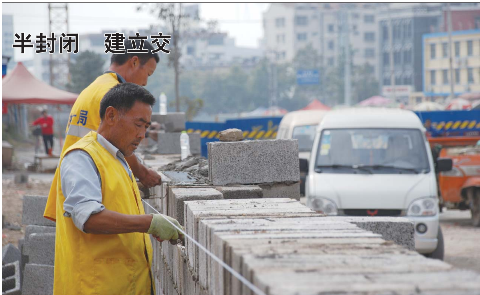
15日，施工人员在枣临铁路解放北路段，开始垒砌围墙。据施工人员介绍，他们将在解放路铁路北面道路两边各垒一百多米的围墙，之后居民可在围墙内侧通行。围墙高1.6米至1.8米、宽0.4米，围墙工期为三天，三天后他们将动工挖地道。 本报记者 赵艳虹 摄影报道
