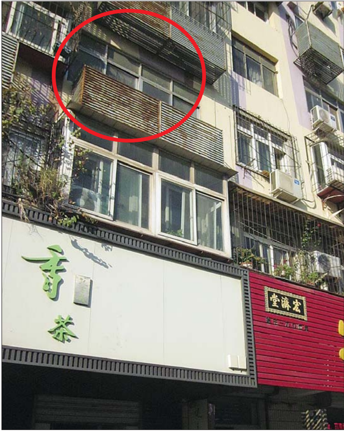
一些老小区的装饰栏(红圈内)锈蚀比较严重。本报记者 孟敏 摄
