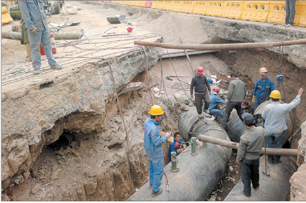
进行合龙。19日,二环东路与花园路交叉口,供热供水回水管道正在
