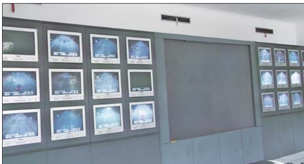
目前隧道安全主要靠摄像头监控。
