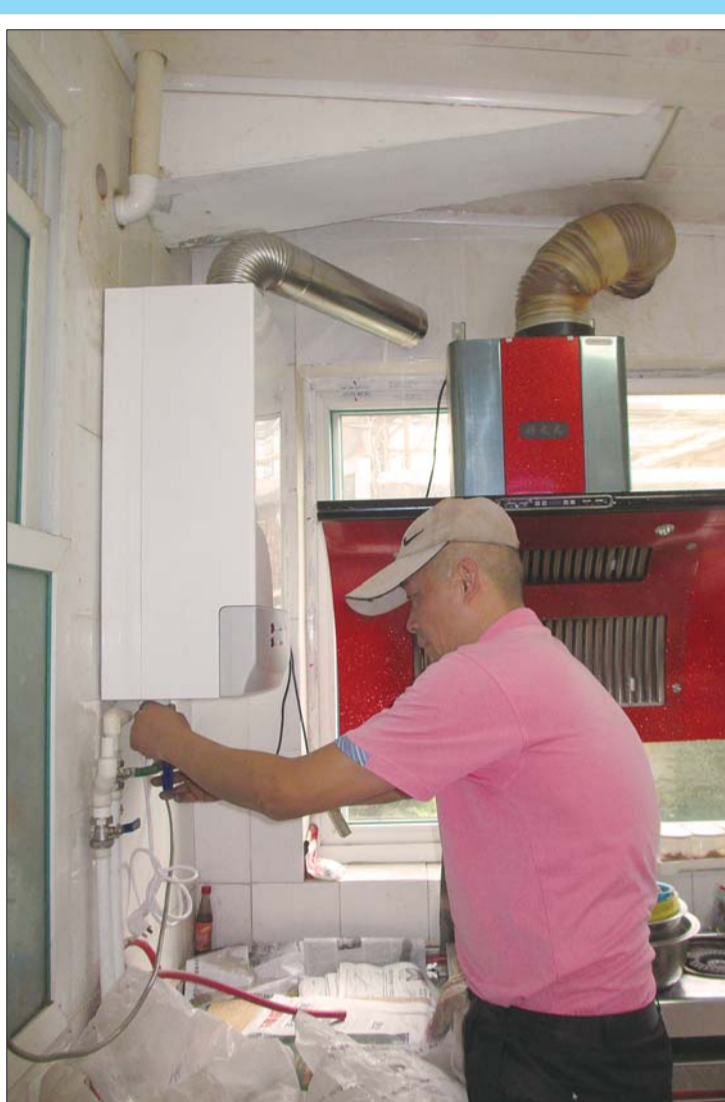
在西八里洼512号院,施工人员正在安装燃气壁挂炉。 本报记者 赵丽 摄
