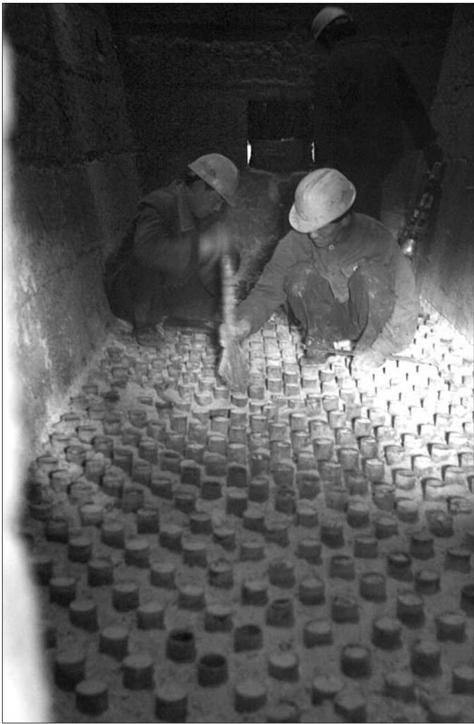
在潍坊一家热力公司,工人正在锅炉内部更换风帽,以保证供暖后煤炭的充分燃烧。
