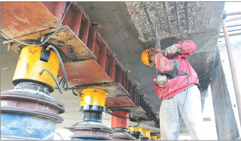
23日,一位工人在桥下工作。身后的桥体被千斤顶支撑。本报记者 邱志强 摄
