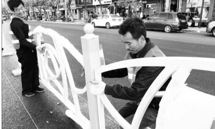
23日,西四路以西的济南路上,工作人员正在新修好的路上安装隔离护栏,据工作人员介绍,“济南路面施工基本完成,路上隔离护栏安装工作从23日开始,将持续一周左右,护栏安装完成后道路标线设置等工作将陆续展开。” 本报记者 段学虎 摄影报道
