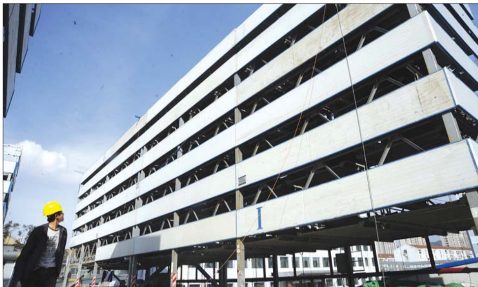
肿瘤医院西侧立体停车场的几组库房已搭建完毕。记者 李泊静 摄
