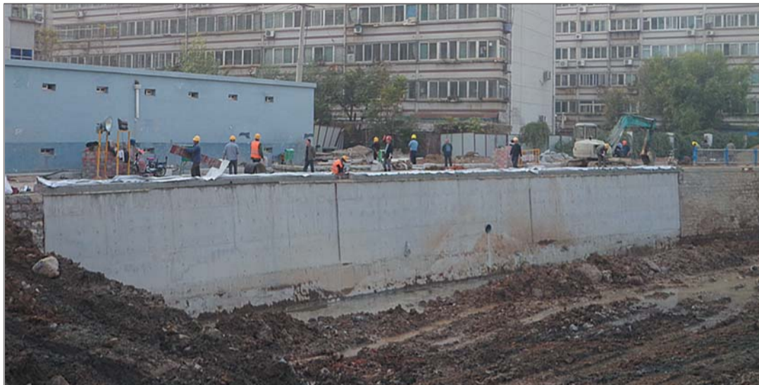
坍塌河堤修复工程主体已经完工，河堤上几名工人正在清理施工现场。 见习记者 叶嘉利 摄
