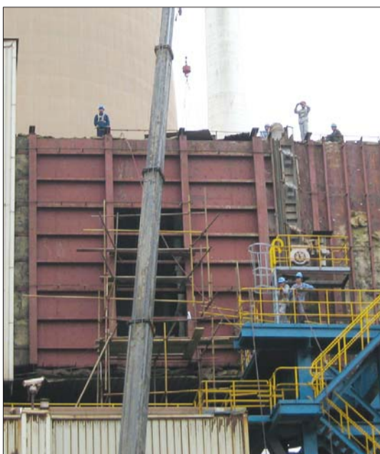
拆除脱硫烟气旁路要用吊车协助。朱夏雅南 摄
