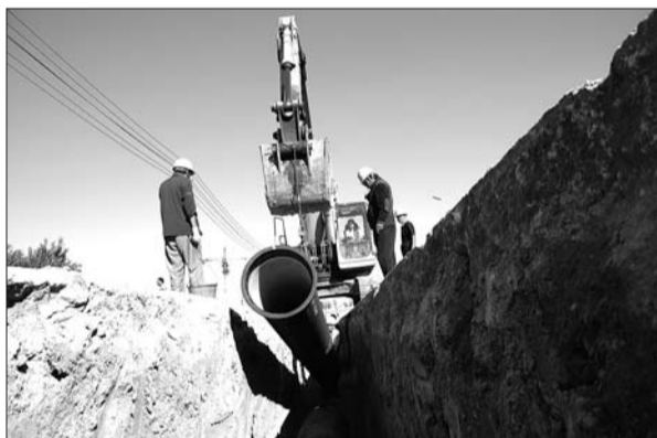
▲26日,连云港路配水管道安装顺利完工。 本报通讯员 孟华 摄
