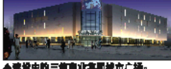
▲建设中的三街商业街区城市广场。
