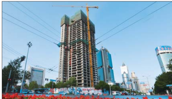
2012年9月9日,大众传媒大厦主体工程封顶。本报记者 徐延春 摄
