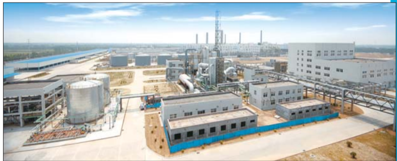
▲位于黄河北的裕兴化工厂新厂区。
