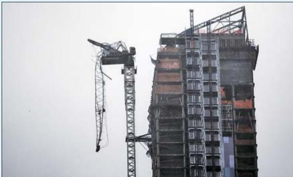
29日,纽约一处建筑工地,一架巨大的起重机因吊臂无法承受巨大风力而折断。
