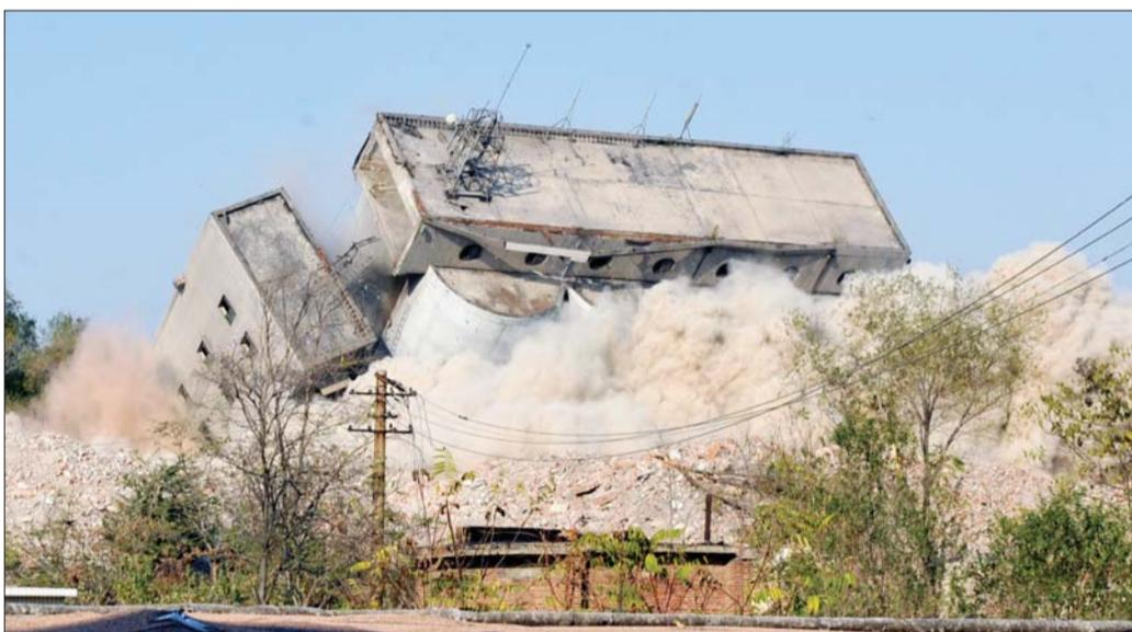
30日15时18分,随着一声巨响,济南白马山啤酒厂8个麦芽仓库应声倒地。该建筑约3500吨,是框筒结构,像这种结构的建筑物用爆破成功拆除,在我省尚属首次。本报记者 张中 摄
