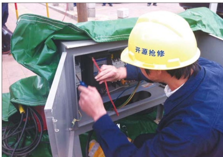
抢修工人正在调试发电机的电表。曹思扬 摄
