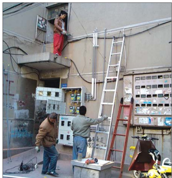
施工队在给灵山小区装天然气。 本报记者 陈新 摄
