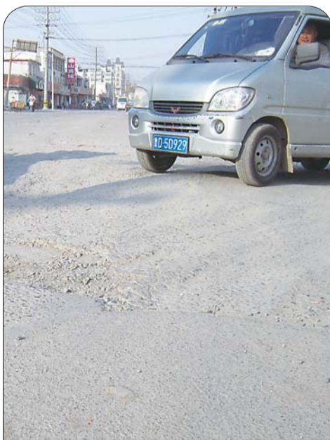
今起石岭路 封闭施工40天
