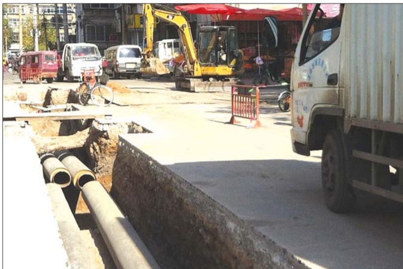
棋盘小区内的路面刚铺好不久再次挖开。本报记者 王倩 摄
