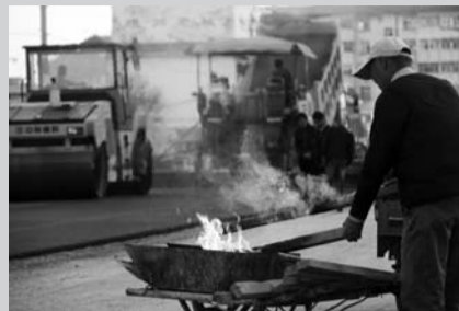
旁边燃起的火堆,以烤掉工具上凝固的沥青。
