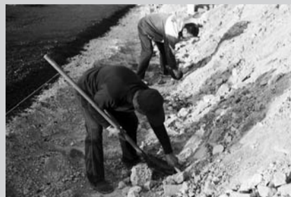
工人们抓紧时间擦除工具上残留的沥青。
