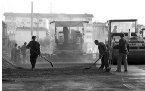
施工人员正在忙着铺设沥青。
