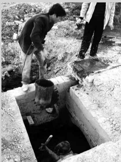
工人正在清除遗落在排水管道里的杂物。
