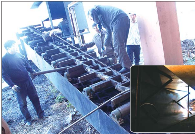
山海天供热站的工作人员正在对锅炉设备的除渣系统进行清理。
