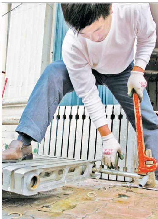
近日,在西北山旧货市场,水暖店梁老板一直忙着为客户修理问题暖气片。梁老板介绍,正式供暖前这段时间比较忙,根本没有时间上门服务维修。本报记者 王震 摄影报道
