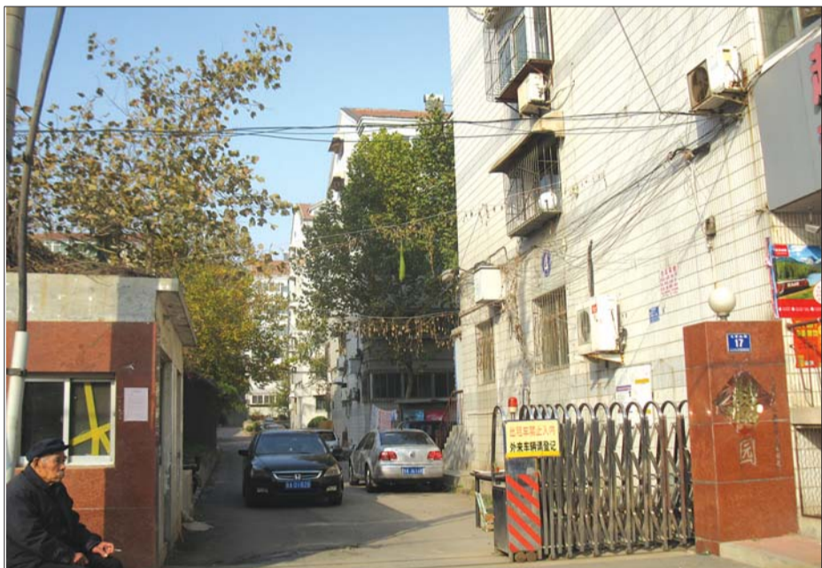
七里山路玉园小区属于自管站供暖,到目前为止,168户居民家中暖气片仍冰凉。 本报记者 焦守广 摄
